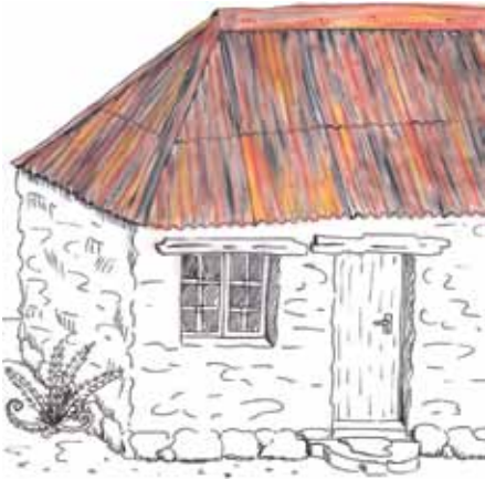
Figuur 5: Die lagie sink op hierdie daksinkplaat het al verweer.
